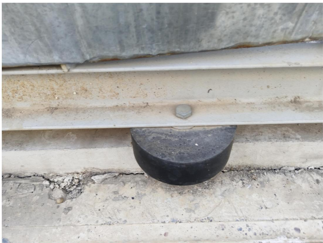
图 3-7 设备减震
