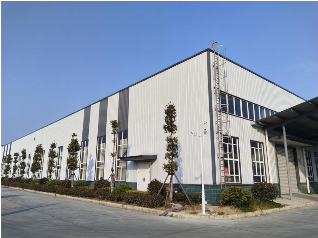
图 3-5 厂区绿化，封闭厂房隔音
