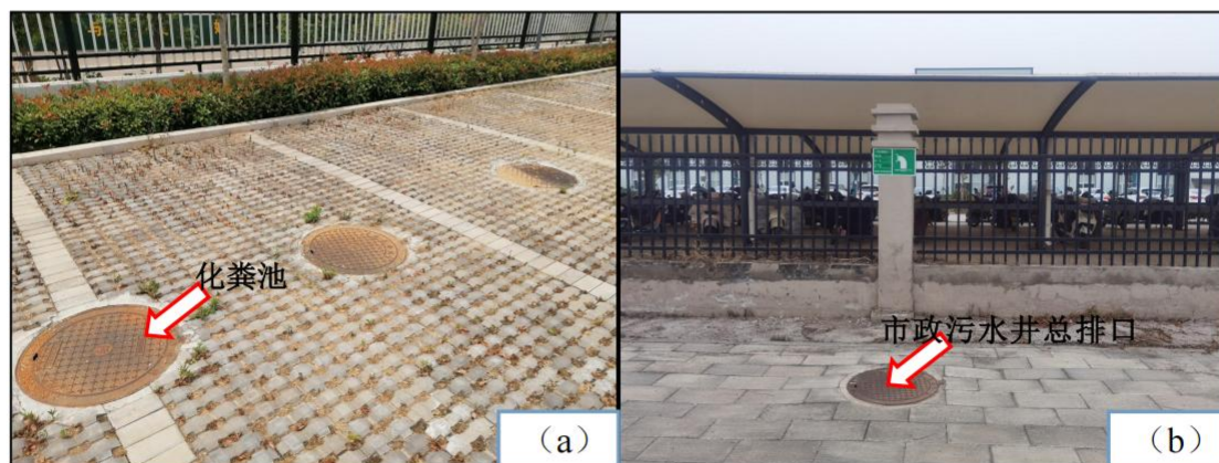
图 3-1 厂区污水处理设施现状图：（a）厂区化粪池；（b）市政污水井总排口
