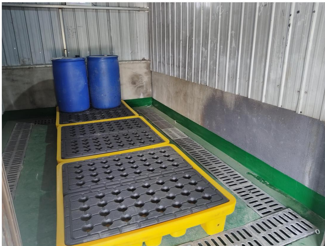
图 3-8 项目危险废物暂存间设置情况
