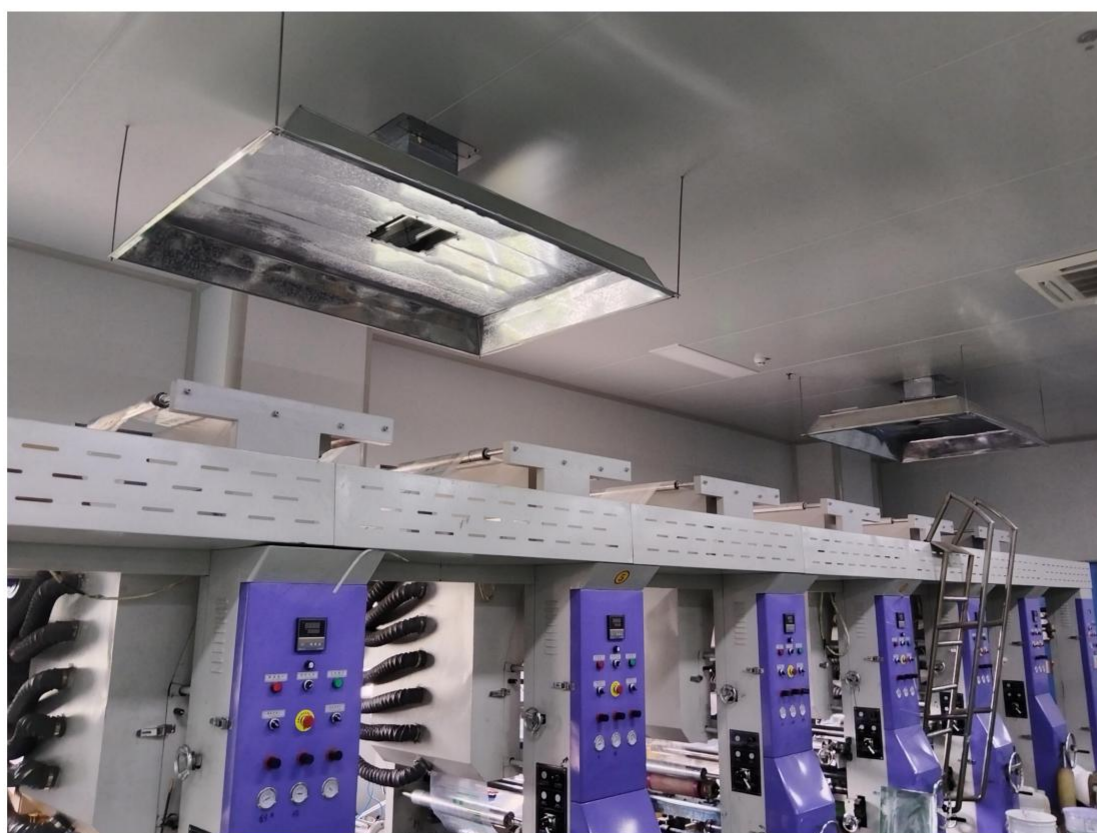
图 3-2 车间废气收集装置
