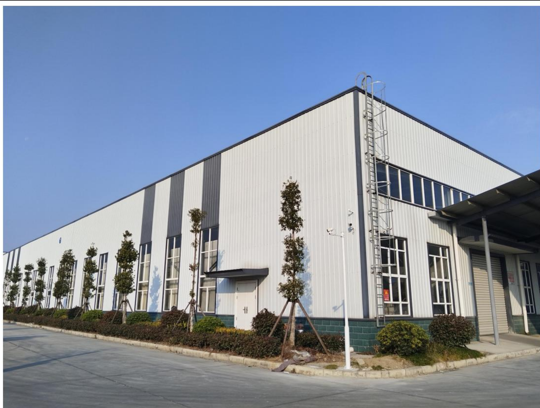
图 3-5 厂区绿化，封闭厂房隔音
