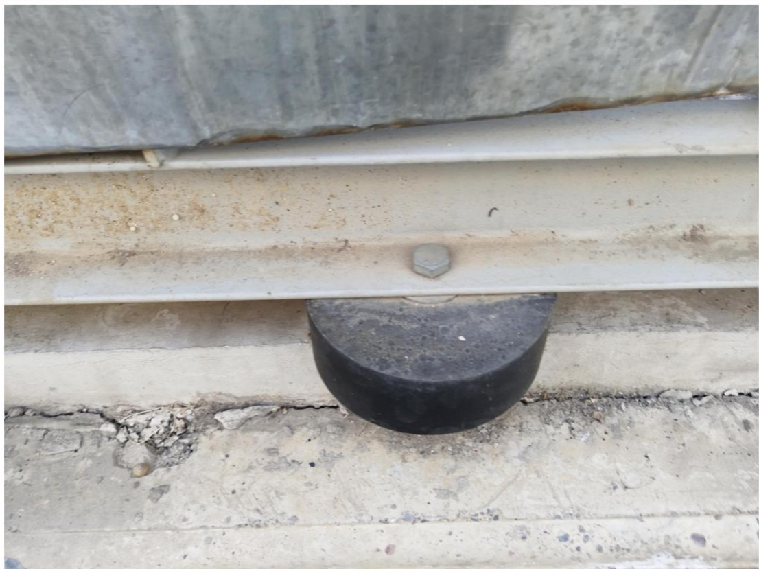
图 3-7 设备减震
